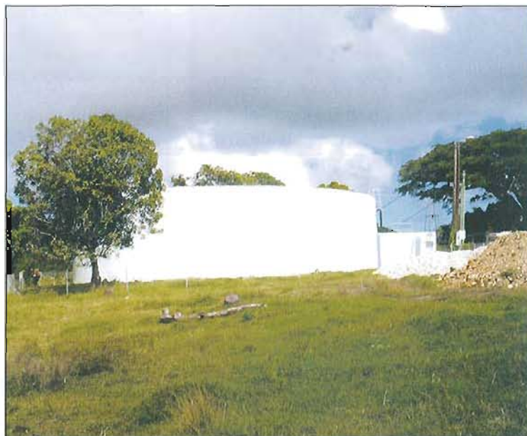
Le nouveau réservoir de morne Lolo va accroître la capacité de stockage, permettant une amélioration de la distribution sur Marie-Galante.
